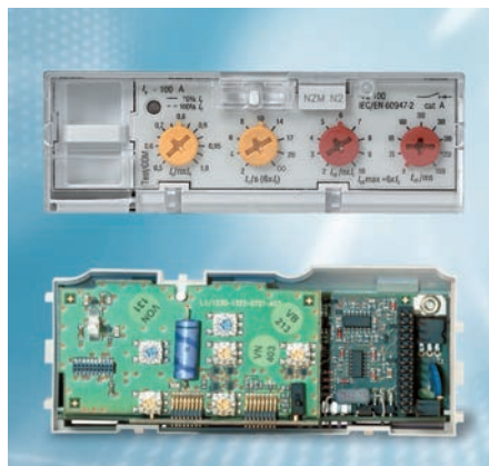
Микропроцессорный расцепитель обеспечивает длительную надежность
