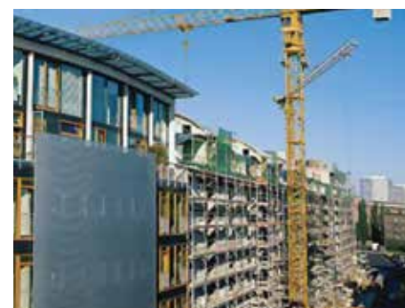
Строительство крупных торговых и складских комплексов
