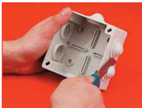
Срезаем кабельный ввод
