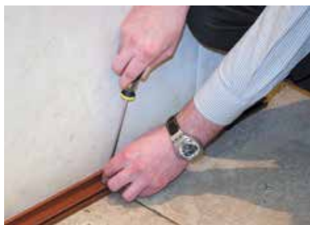
Основание короба крепится к полу, вплотную к стене, замком наружу
