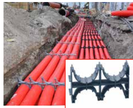
Рис.1 Применение кластеров для многорядовой кабельной канализации.
