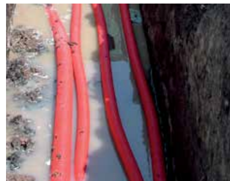
Рис.1 Применение кластеров для многорядовой кабельной канализации.
