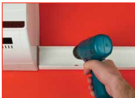
Закрепите основание короба на стене
