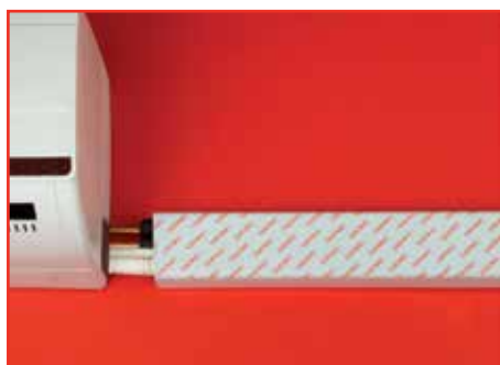
Закройте смонтированную трассу крышкой
